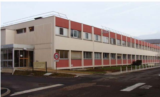
Vue du bâtiment 17 qui héberge le personnel du Service de santé au travail (SST) ainsi que le Laboratoire d'analyses de biologie médicale (LABM). © CEA
