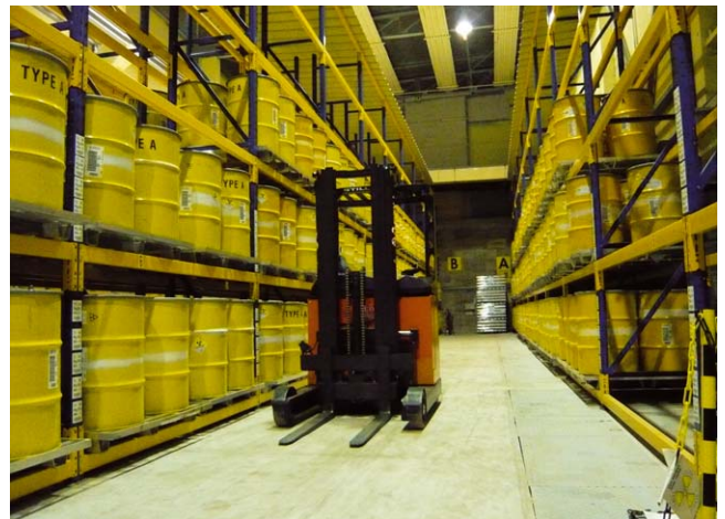
Entreposage de fûts de déchets solides faiblement actifs dans le bâtiment 91. © CEA
