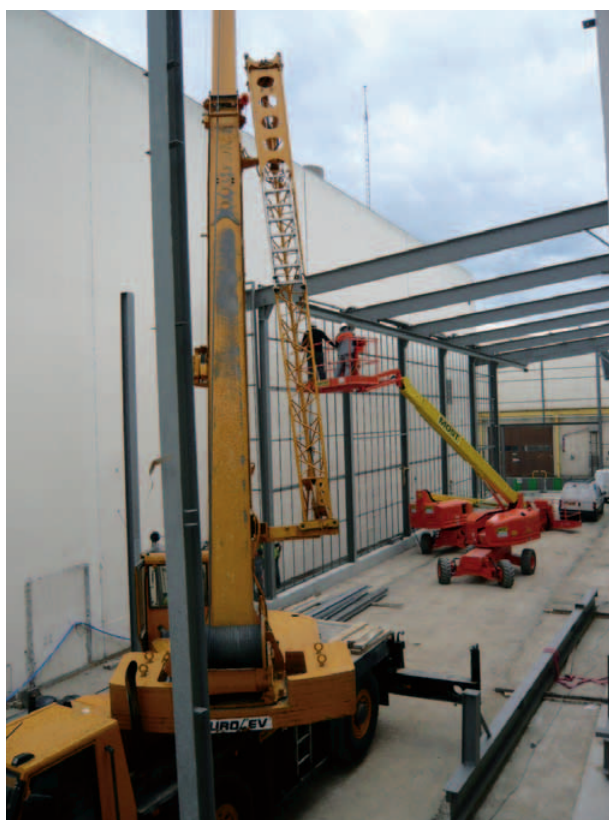
Construction du bâtiment 90
