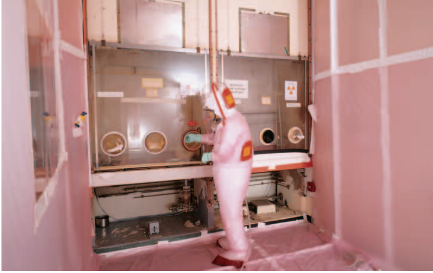
Opérateur en tenue ventilée lors d'une opération d'assainissement
