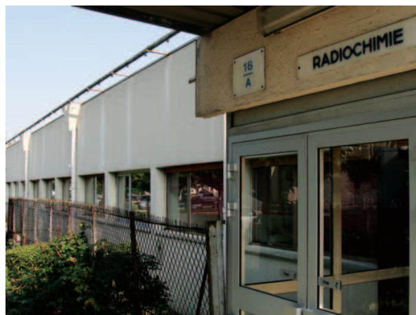
Bâtiment 18 de l'INB 165
