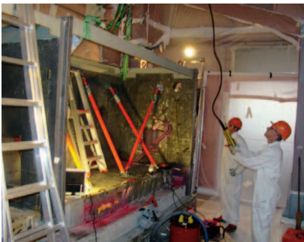
Démantèlement de la chaîne de cellules blindées AGA
